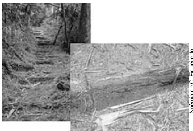
Figura 22: Patamares inclinados contidos por troncos de madeira.
