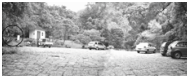
Figura 10: Platô da Barragem – nível mais baixo.
