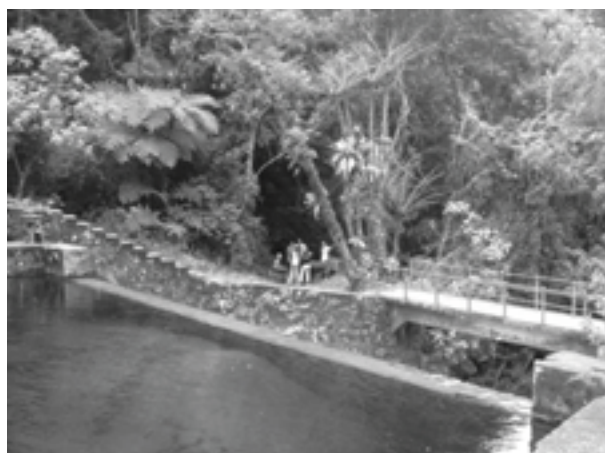
Figura 15: Vista da barragem e ao fundo a ponte de concreto.
