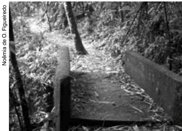
Figura 24: Ponte de concreto.
