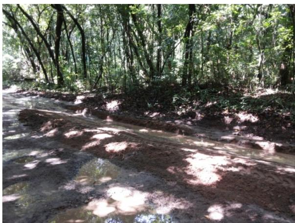
**Figura 76:** Estrada de acesso à FLONA na estação chuvosa, com buracos, lama e poças d'água. Fonte: acervo fotográfico da FLONA Restinga de Cabedelo. Data: julho de 2013
