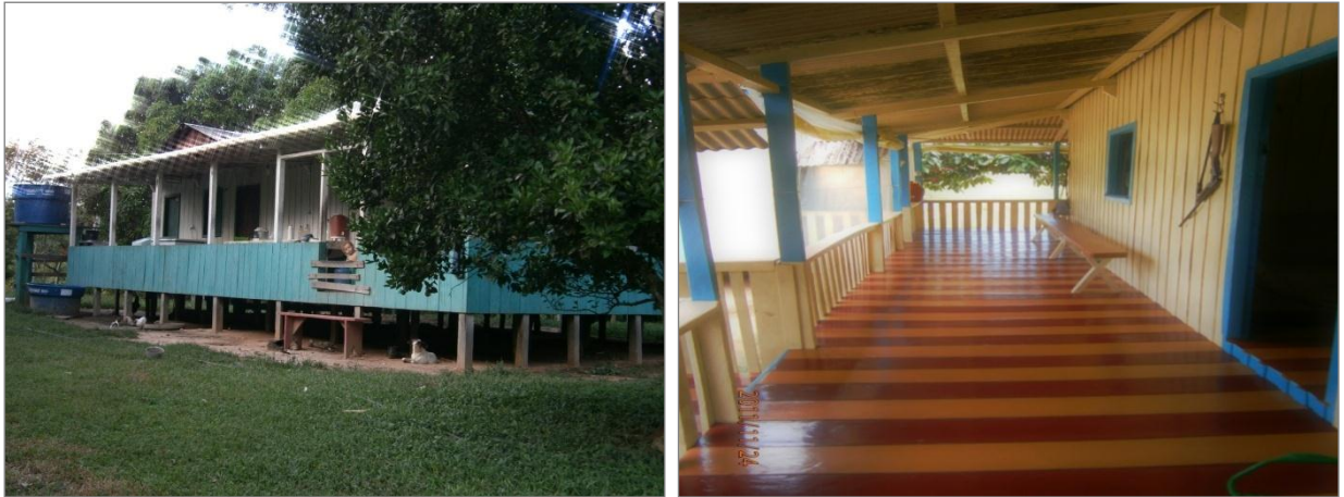
Figura 41: Moradias construídas no Projeto de Assentamento com subsídios do Programa Crédito Moradia. Fonte: Dados da pesquisa.
