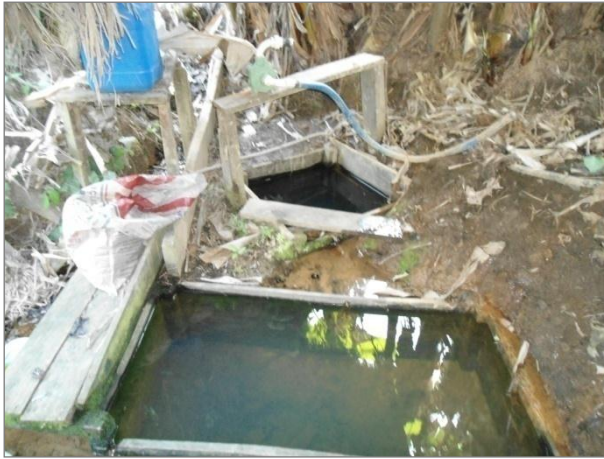
Figura 17: Cacimba utilizada para captação de água - Colocação Centro do Marco II, Seringal Boa Vista/Resex Chico Mendes.
