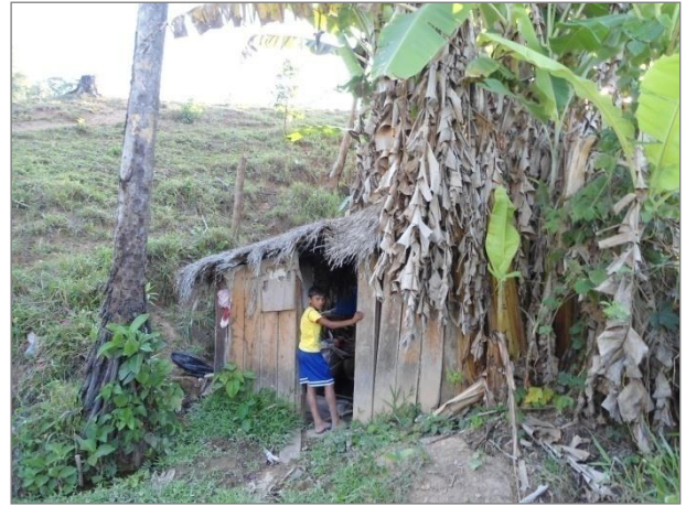
Figura 18: Casinha utilizada para proteger a cacimba de animais - Colocação Centro do Marco II, Seringal Boa Vista/Resex Chico Mendes.
