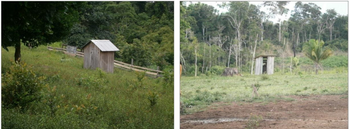
Figura 43: “Privadas” construídas na colônia Boa Jesus (a) e na colônia Asa Branca (b).
