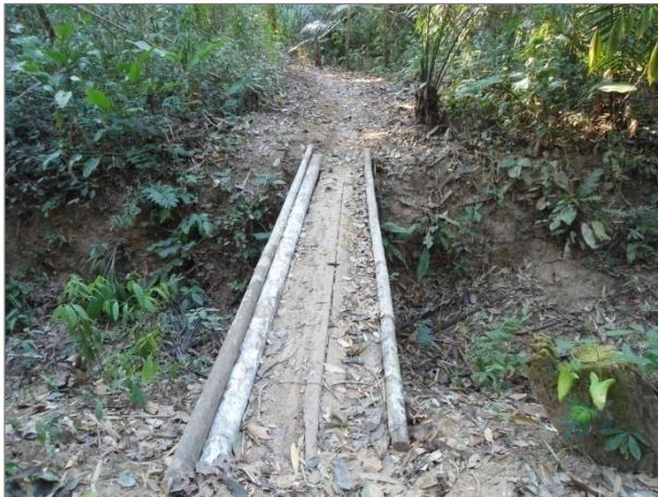
Figura 34: Ponte construída com Itaúba ( Mezilaurus itauba ) - Colocação Quatro Bocas I - Seringal Boa Vista/Resex Chico Mendes.
